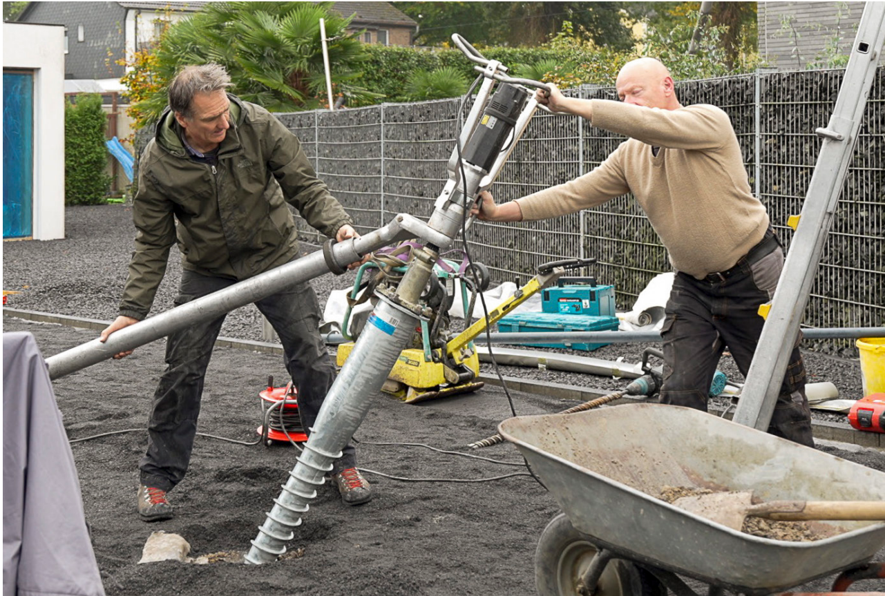
Die Schraubfundamente können je nach Bedarf in verschiedenen Winkeln in den Boden geschraubt werden.
