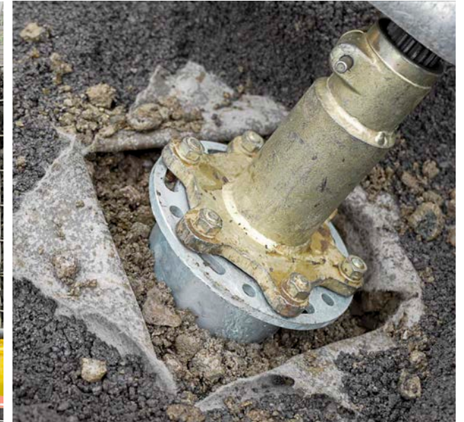
Die Schraubfundamente können je nach Bedarf in verschiedenen Winkeln in den Boden geschraubt werden.
