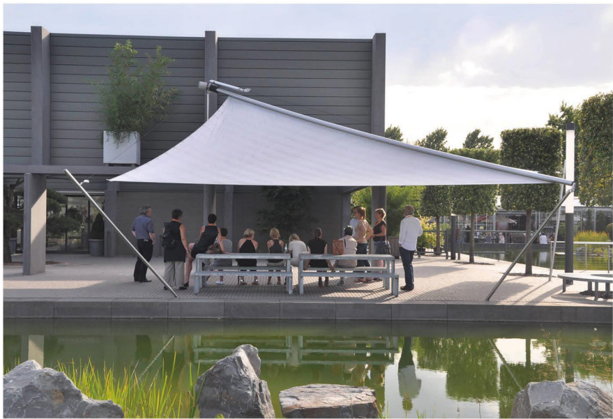
das fertig montierte Sonnensegel
